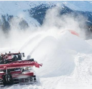
**7** Iglu Former© mittels Fräse mit Schnee vollständig überdecken. Mindestdicke 1 Meter.
