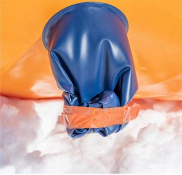
**3** Befüllschlauch mit Klebeband verschliessen.
